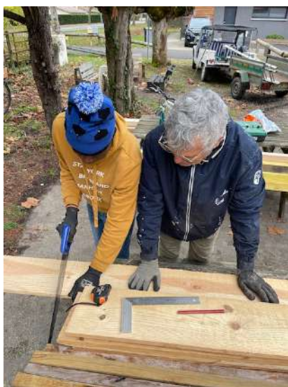
Atelier bricolage animé par des bénévoles : construction d'un abri à vélo
